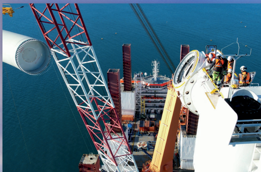
MPI Resolution - Jack-up Vessel impiegato per l'infissione dei monopali e l'installazione delle turbine di Beleolico
